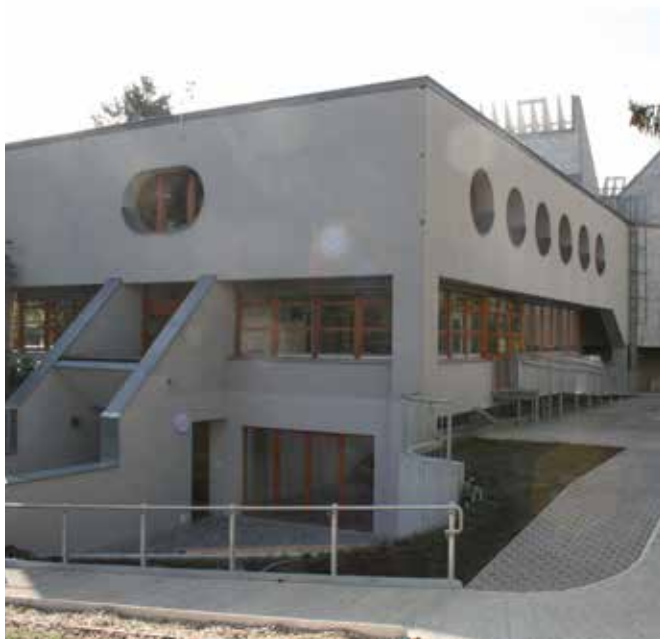
DER UMBAU IN GLANZING BRACHTE NEBEN NEUEN PFARR- UND KINDERGARTENRÄUMEN AUCH BARRIEREFREIHEIT.
