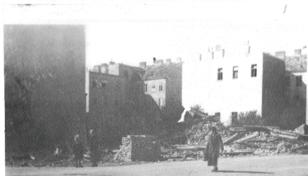
Das zerstörte Schneider-Haus von gegenüber gesehen; links die Kirchenmauer
